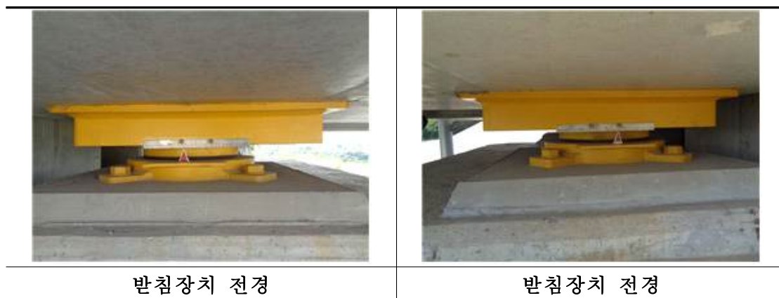
<그림 2.9.13> 교량받침 전경
