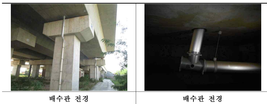
&lt;그림 2.2.4&gt; 배수시설 전경
