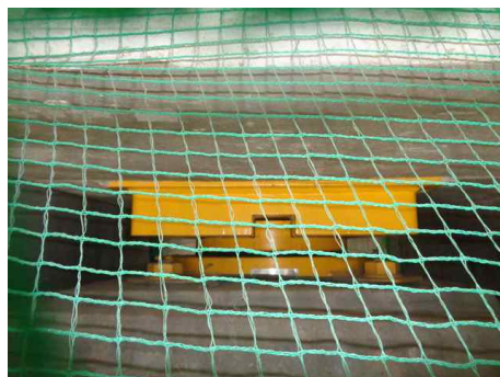
받침장치 상태 양호
