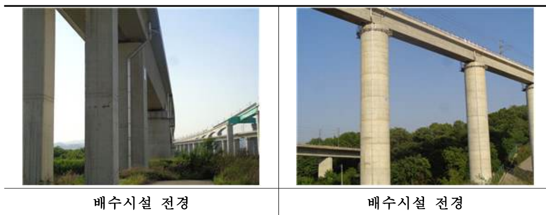
<그림 2.10.4> 배수시설 전경
