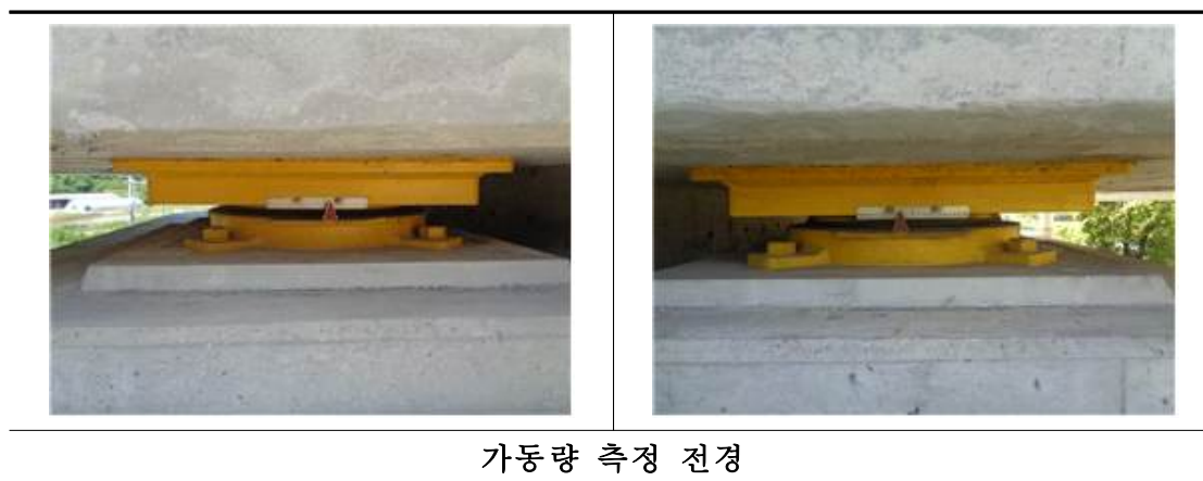
&lt;그림 2.11.16&gt; 교량받침 가동량 측정
