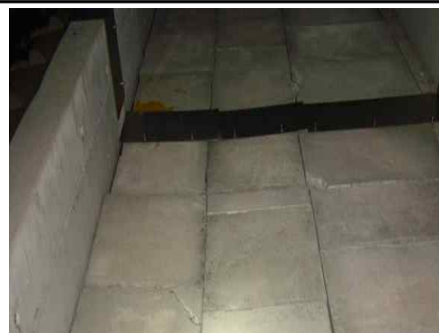
신축이음 상태 양호
