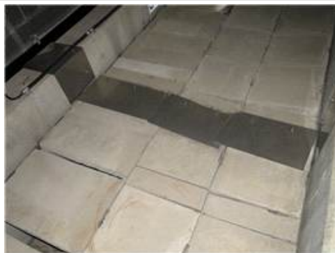
신축이음 상태 양호
