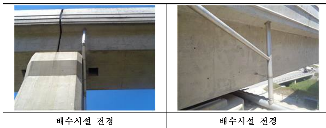
<그림 2.11.4> 배수시설 전경
