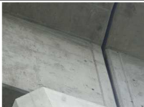
신축이음 상태 양호
