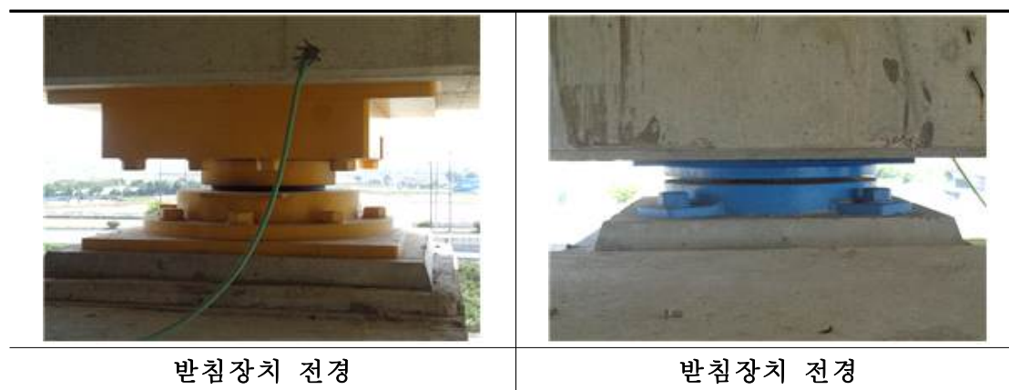
&lt;그림 2.6.13&gt; 교량받침 전경
