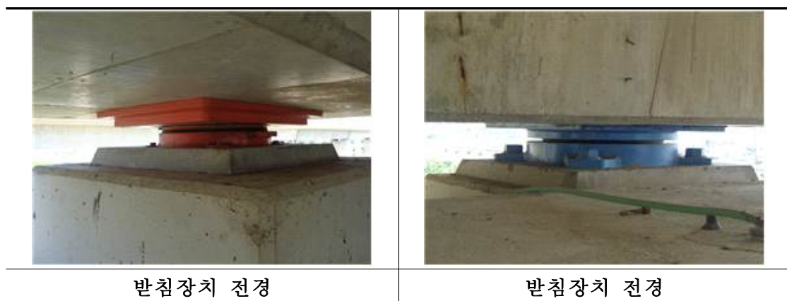
<그림 2.5.13> 교량받침 전경
