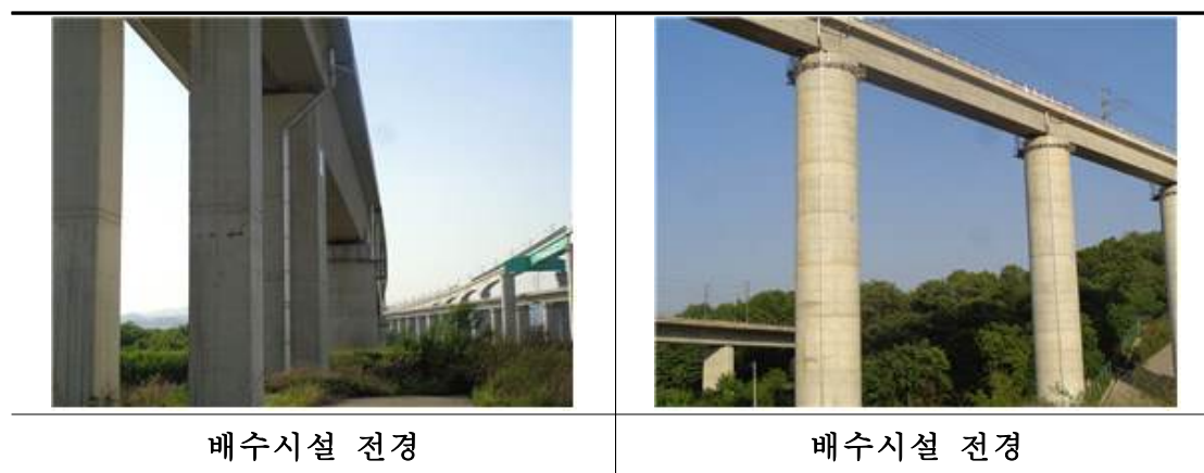
<그림 2.9.4> 배수시설 전경
