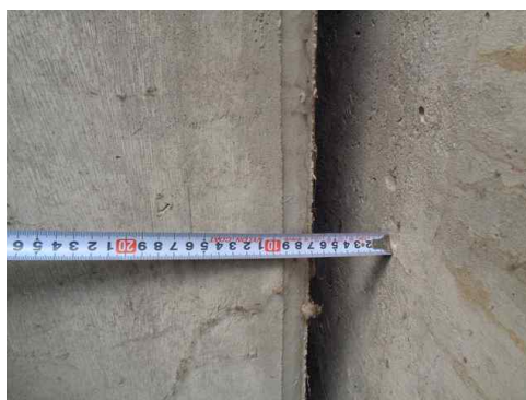
신축이음 유간거리 측정 전경
