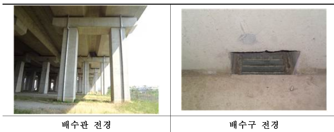
<그림 2.6.4> 배수시설 전경
