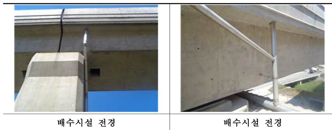
<그림 2.12.4> 배수시설 전경
