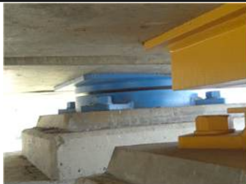
받침장치 상태 양호
