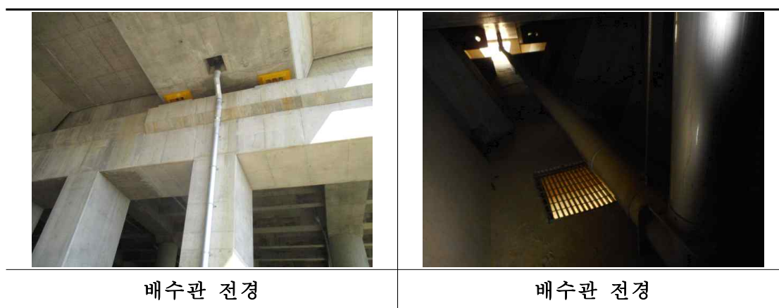
&lt;그림 2.1.4&gt; 배수시설 전경
