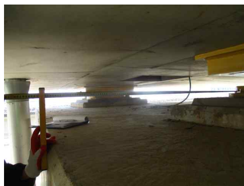
<그림 2.1.13> 교량받침 연단거리 측정
