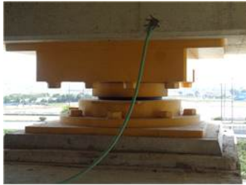
받침장치 상태 양호
